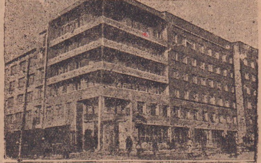
На фото сверху — дом быв. Лаврентьева по ул. Красной Армии, в доме помещалась контора «Хлебопродукт» 1929 г. Внизу — здание гостиницы, выстроенное на месте этого дома. (1930 г.). На рисунке — сравнительная величина гостиницы и снесенного дома (обозначена штрихом).
