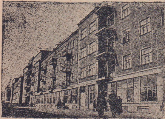
Начало реконструкции. Новый дом на улице Громобоя в местечке Ямы — один из домов будущей центральной части города.
